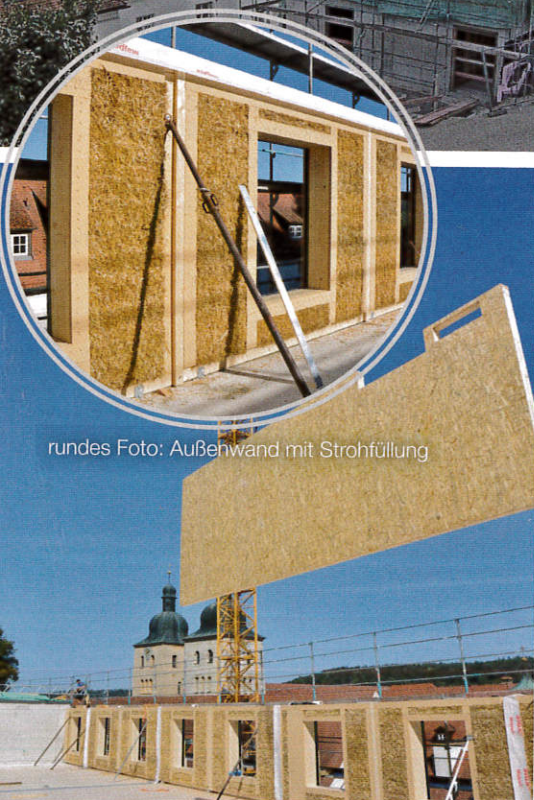
Eine Trennwand innen wird per Kran „eingeflogen“ Alle Fotos von Herrn Lorenz Märkl
