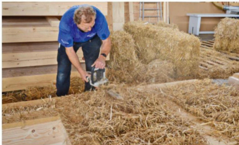
Feinschliff mit der Kettensäge: Das eingebaute Stroh wird gekürzt.
